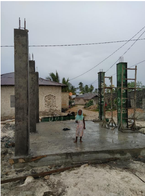
Tweede fase in de bouw van de drink-waterinstallatie in Kichakanyuki (Jambiani)
